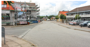
Krydset ved Møldrupvej og Jyllandsgade
