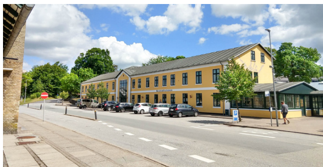
Busbane og midlertidige p-pladser ved stationen.
