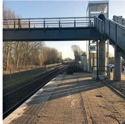
Gangbro over jernbanen, Støvring station
