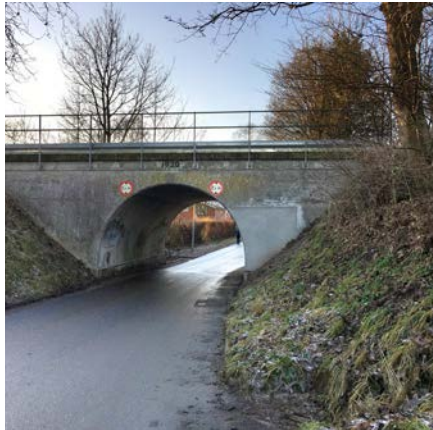
Gennemgang under banen sydvest for projektarealet
