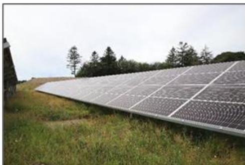
Figur 6: Solceller monteret på faste stativer.
