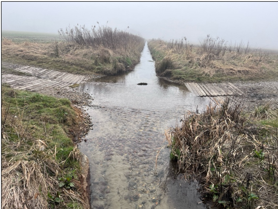
Vadestedet i Hylstrøm som har afløst et rør.
