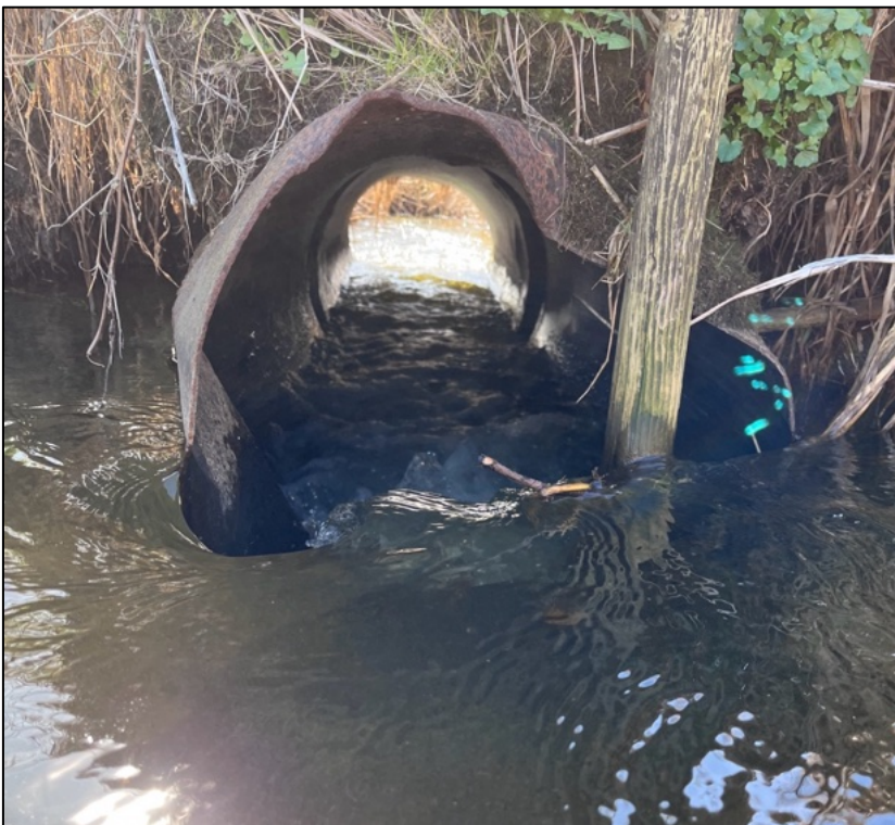
Røret set fra opstrøms side
