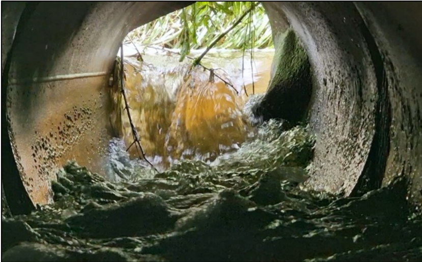
Røret set fra nedstrøms side
