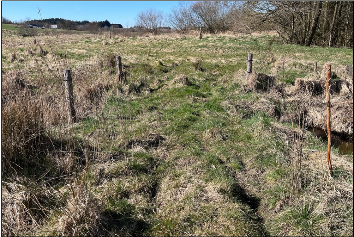
Rørunderføringen set fra øst. Her etableres vadested
