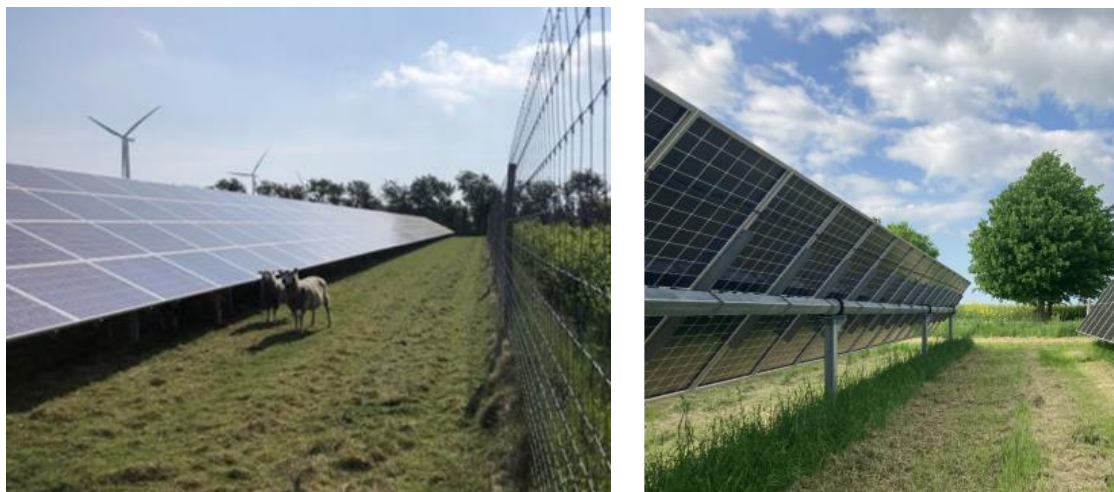
Figur 3-4 Solcellepaneler på faste stativer (venstre) og på trackerstativer (højre)
