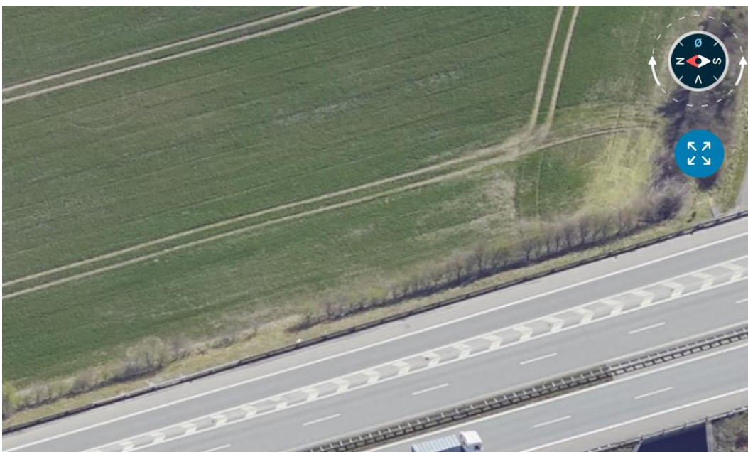
Figur 1-18. Læhegn på den vestlige projektgrænse ud mod Nordjyske motorvej. Billedet er taget fra skraafoto.dataforsyningen.dk.
