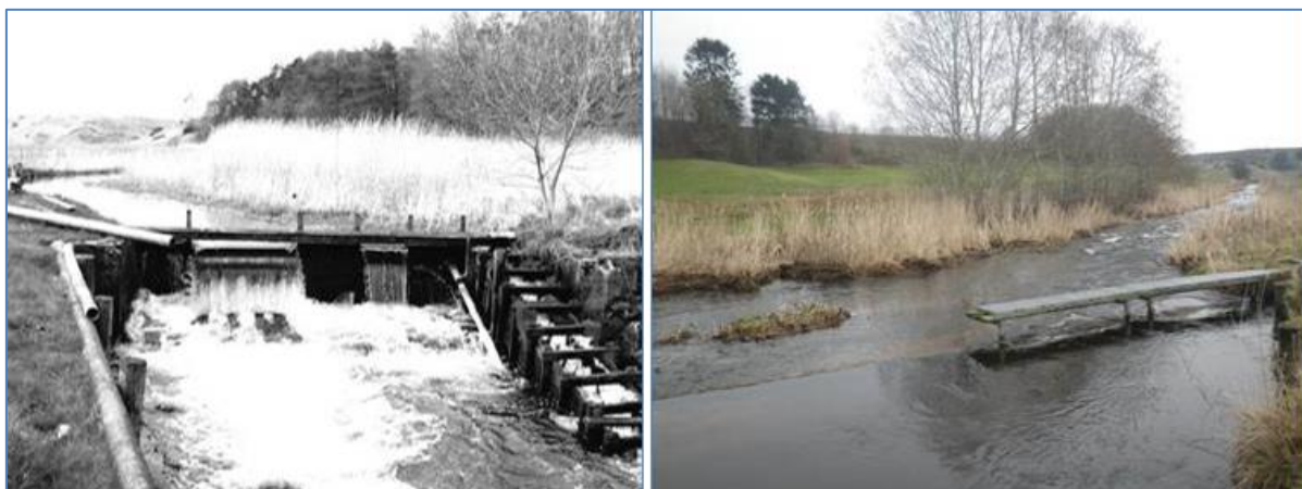
Stemmeværket med modstrømstrappe ses til venstre og det nuværende stemmeværk med stryg med indløb med lang overløbskant til højre.
