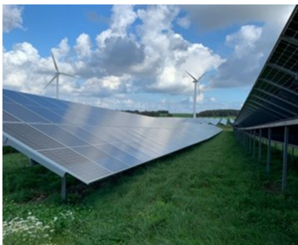
Foto 2: Eksempel på solcellepaneler på faste stativer
