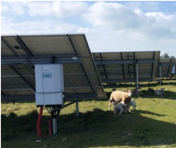
Foto 3: De hvide kasser under solcellerne er invertere, som omdanner jævnstrømmen til vekselstrøm.
