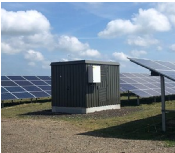
Foto 4: Eksempel på en teknikbygning; her en typisk fordelingstransformer.
