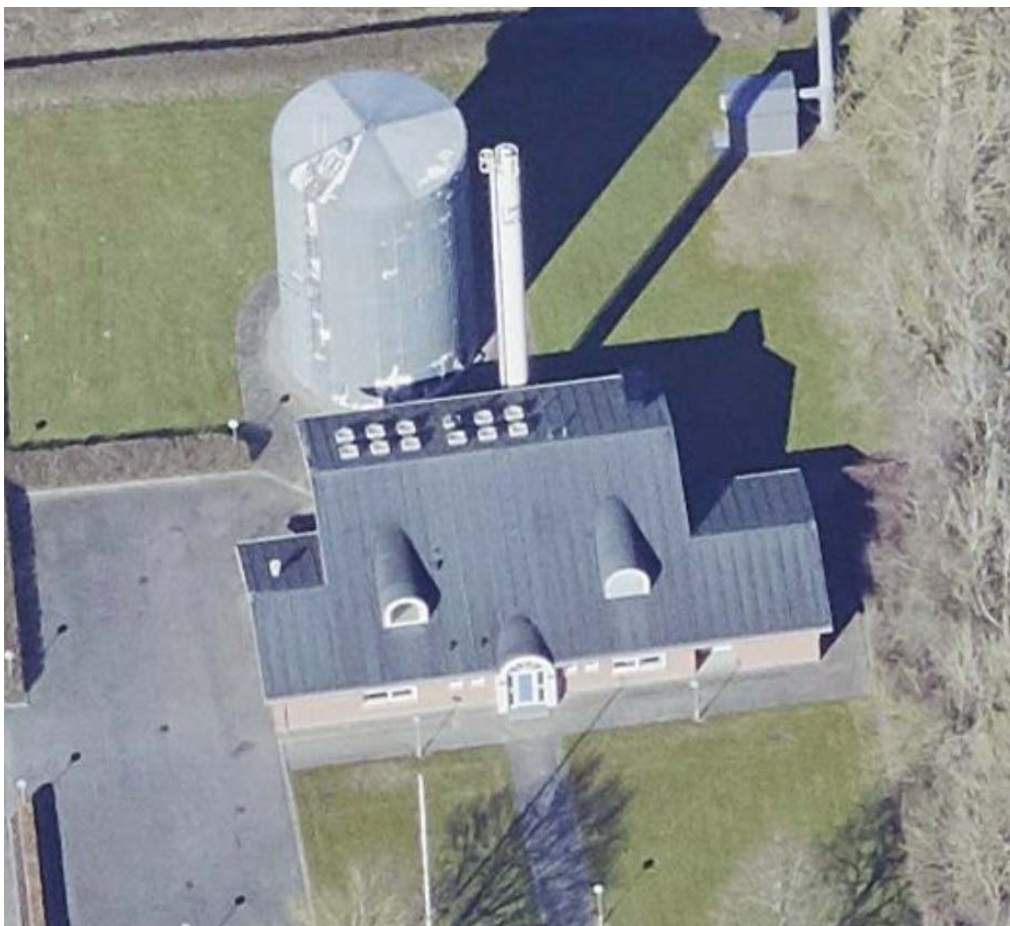
Figur 1, Anlægget på Vesterbygade 36B
