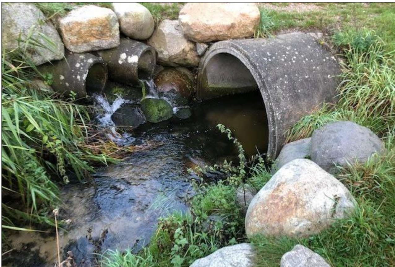
Foto: Mastrup Bæks rørindløb til Mastrup Søerne og udledning af regnvand (WSP september 2021).
