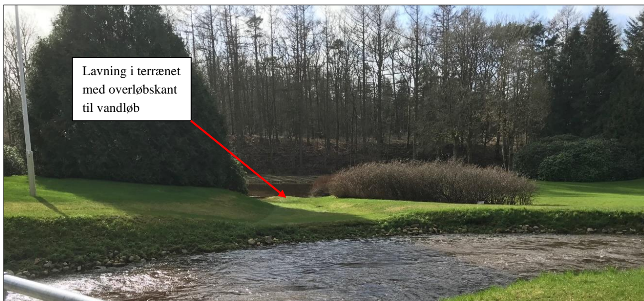
Figur 7-19 Illustration af lavning i terrænet til at styre overløbsvandets forløb og udløb til vandløbet (Foto fra Karstoft Å, Herning Kommune)
