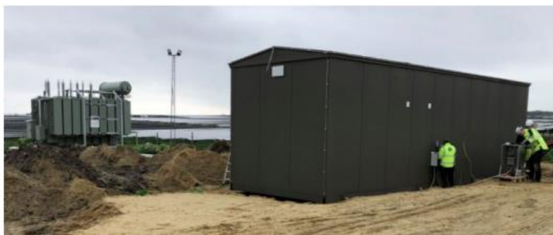
Figur 3-9 Eksempel på effekttransformer til venstre og primær koblingsstation til højre.
