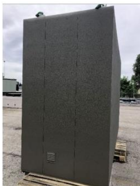
Figur 3-10 Eksempel på sekundær koblingsstation.
