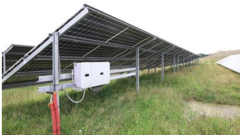
Figur 3-5 Eksempel på inverter (den hvide boks), som placeres under solcellerne. Inverterne omdanner jævnstrømmen til vekselstrøm af solcellepaneler på trackerstativer.
