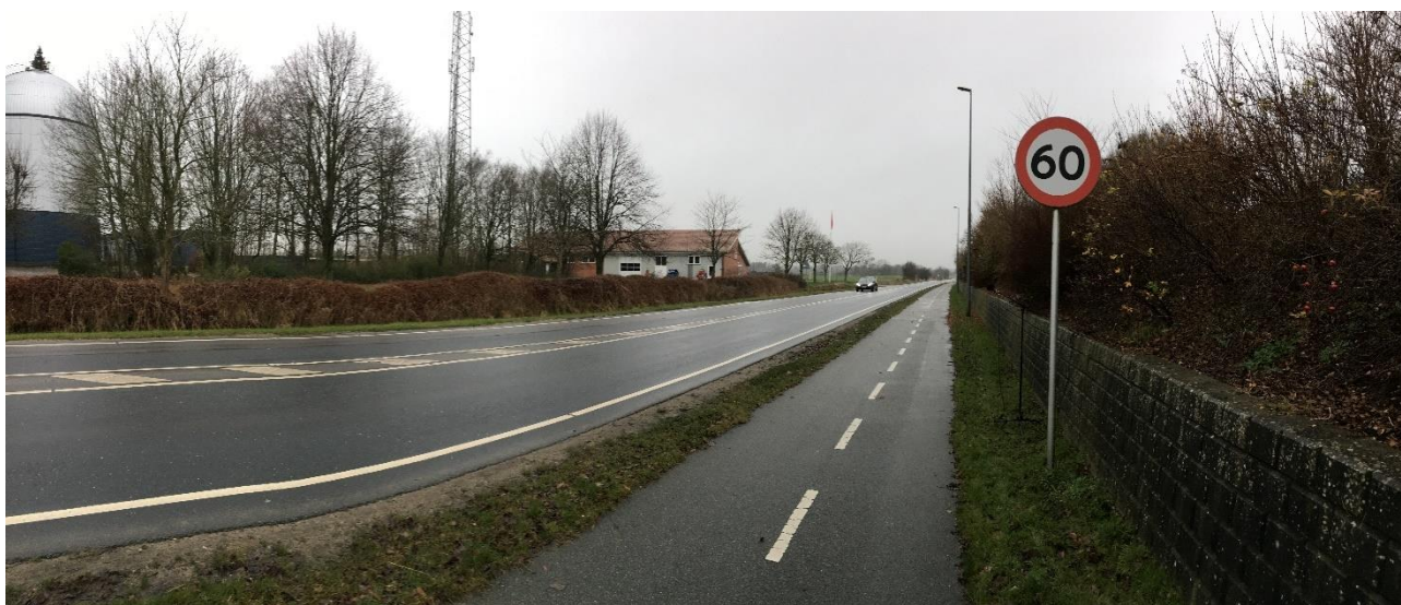
Figur 2 Vestre Primærvej. Til venstre i billedet ses akkumuleringstanken på Støvring Kraftvarmeværk og til højre ses støjvolden.
