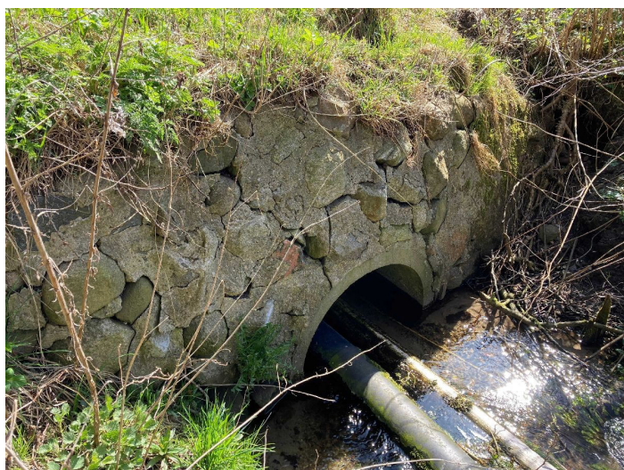
Billede af vejbroens indløbsside og de to dambrugsrør, som ligger gennem rørbroen i dag.
