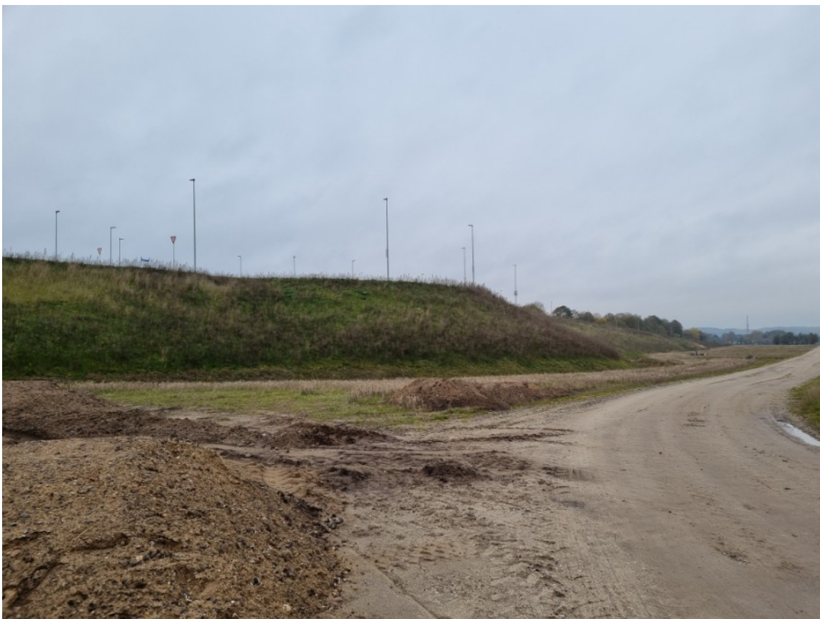
Billede viser skråningsanlægget ved Støvring Ådale vejen. Bagved ses fredskoven foran jernbanen. Foto taget indenfor lokalplanafgrænsningen og i retningen mod kirken.
