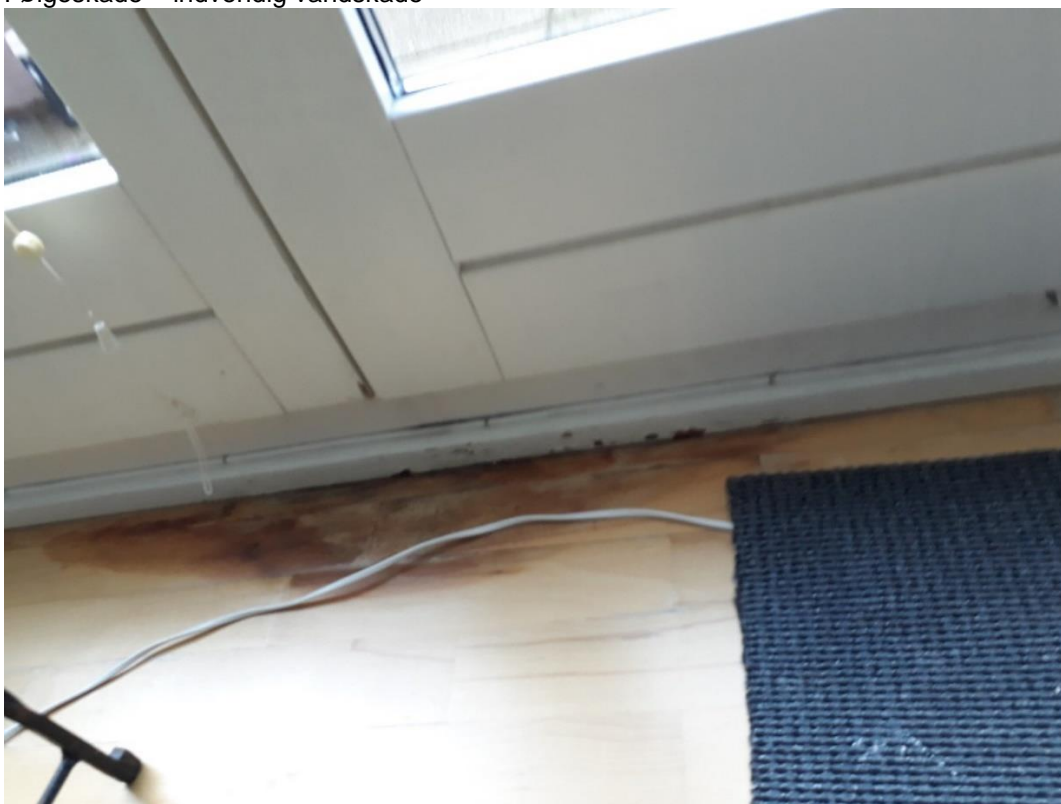
Følgeskade – indvendig vandskade
