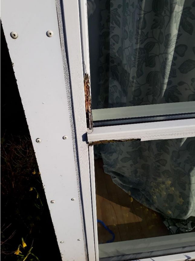
Følgeskade – indvendig vandskade
