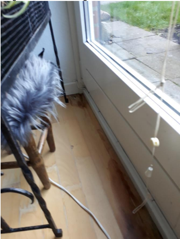
Følgeskade – indvendig vandskade
