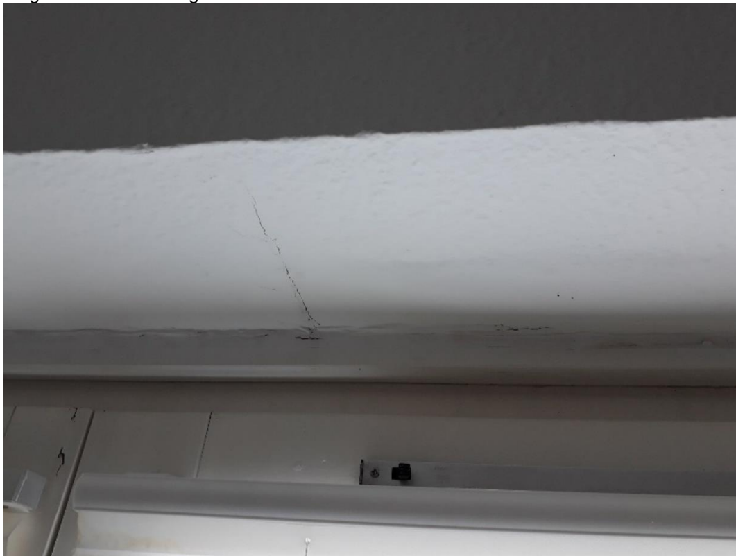
Følgeskade – indvendig vandskade
