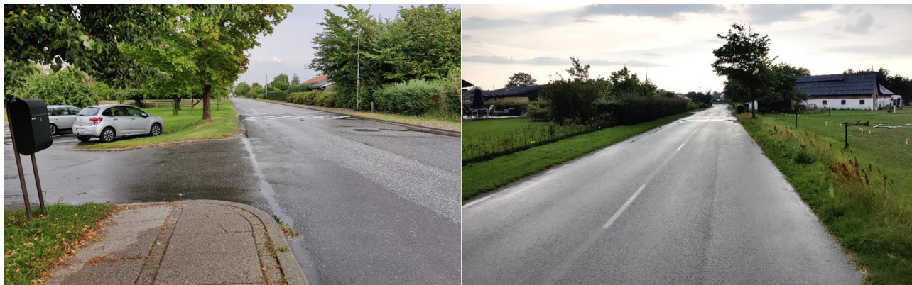
Figur 4 Eksisterende fortov på nordsiden af vejen, samt eksisterende rabat syd for Mølhøjvängen-stiens tilslutning. Se fotos ved alternativ 1, som viser eksisterende beplantning omkring den eksisterende stiftslutning ved Mølhøjvängen, hvor beplantningen har stor indvirkning på oversigtsforholdene
