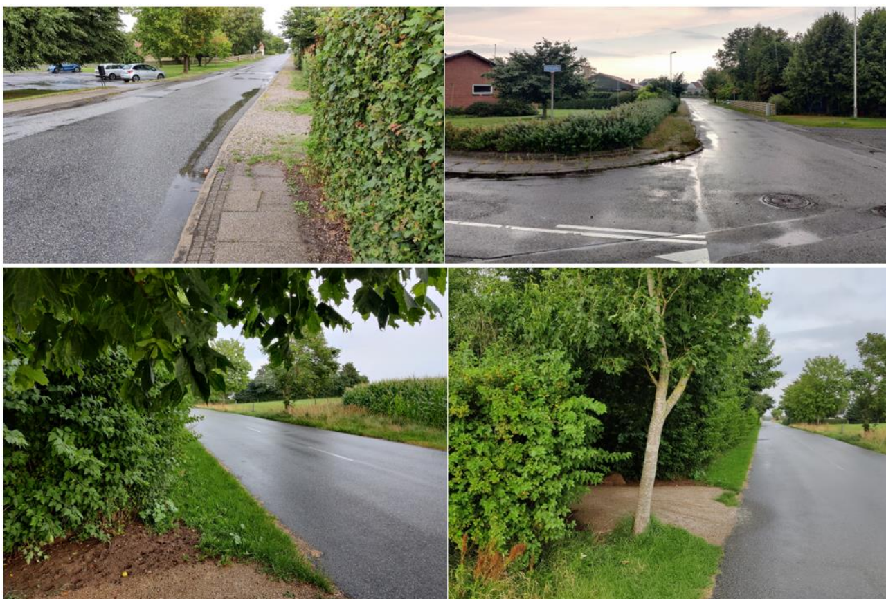
Figur 3 Øverst ses eksisterende fortov på sydsiden af vejen, samt eksisterende fortov ved Tværgade. Nederst ses eksisterende beplantning omkring eksisterende stitilslutning ved Mølhøjvangen, hvilket har stor indvirkning på oversigtsforholdene
