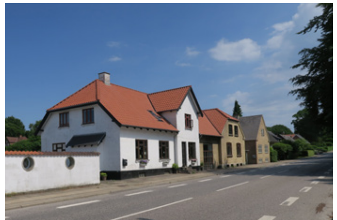
Bebyggelse langs Jyllandsgade. Her ses den karakteristiske tætte bebyggelsestruktur i det oprindelige stationsmiljø
