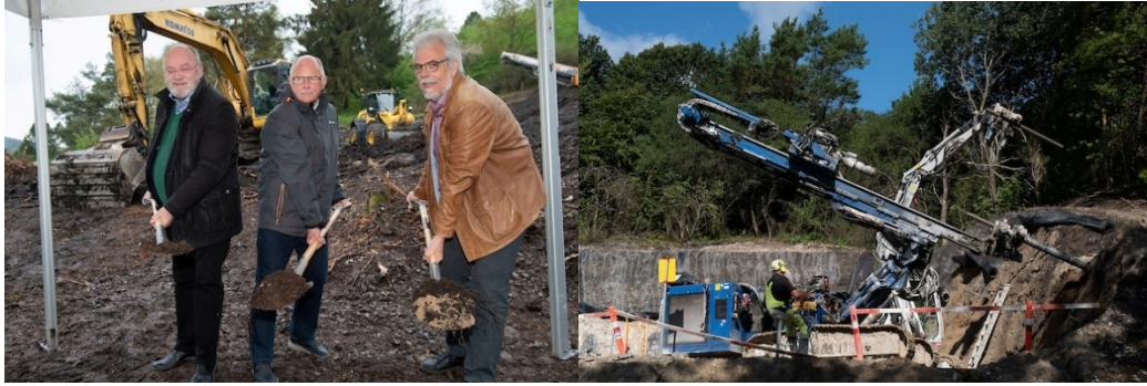
Første spadestik – sikringsankre bores ind i kridtskråningen.
