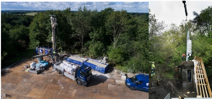
Boring af skorsten til bunkeren – Hejs sænkes ned i bunkerens nødudgang.
