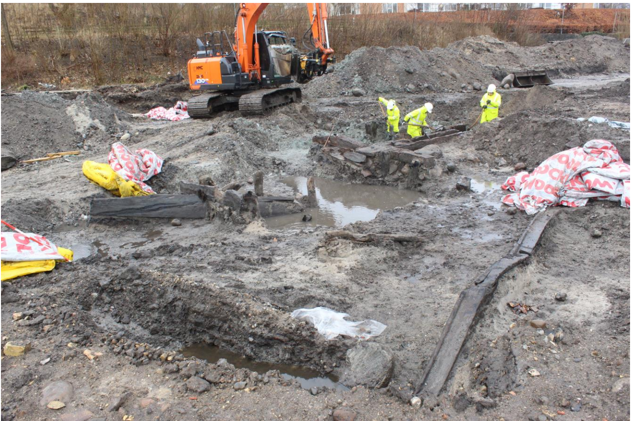
Fig. 4. Fundområde 3. Trækonstruktionerne her stammer fra en ældre udgave af Støvring Vandmølle, som foreløbigt tidsfæstes til 1100-1500-tallet. Kommende årringsdateringer af tømmer fra vandmøllen kan sandsynligvis gøre dateringen meget mere præcis. Udgravningsfeltet set fra sydøst. Foto: Nordjyllands Historiske Museum.
