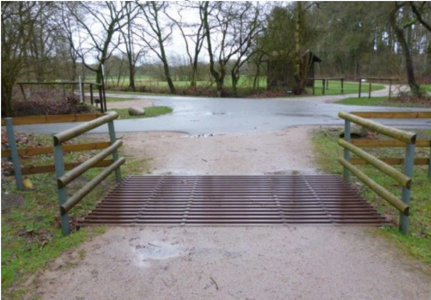
Fig. 1: Færise med firkantede rør.
