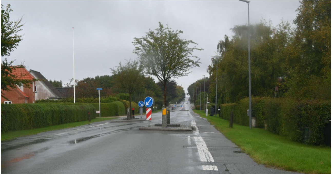
Eksisterende helleanlæg der ønskes renoveret og beplantet med nye, lavere træer for bedre udsyn.
