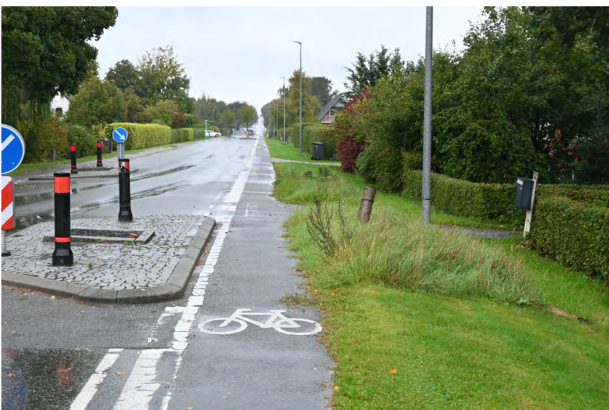
Ikke boget problem med fortov fra byskilt til byskilt
