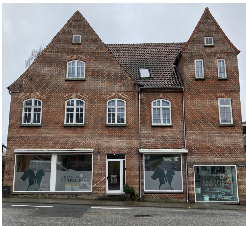
Taget ønskes udskiftet til nyt som oprindeligt i dansk rød vingetegl og facaderne istandsat med reparation af fuger og enkelte steder udskiftes teglsten.
