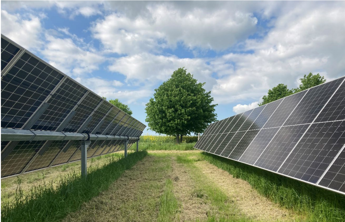
Figur 4 Foto af solcellepaneler på trackerstativer.
