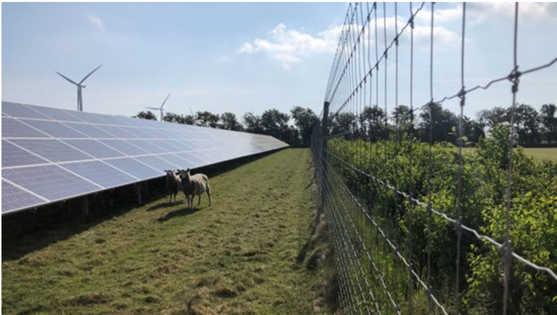
Figur 3 Foto af solcellepaneler på faste stativer.
