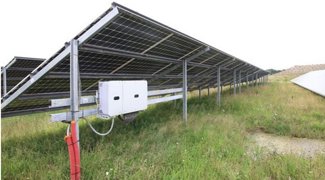
Figur 5 Foto af eksempel på inverter (den hvide boks), som placeres under solcellerne. Inverterne omdanner jævnstrømmen til vekselstrøm af solcellepaneler på trackerstativer.
