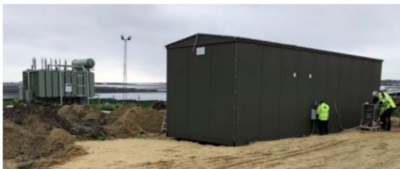
Figur 3-9 Eksempel på effekttransformer tv og primær koblingsstation th.
