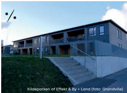
Byggeri som fremstår med hævet plint
