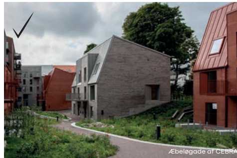
Byggeri med parterreetaage bygget ind i terrænet
